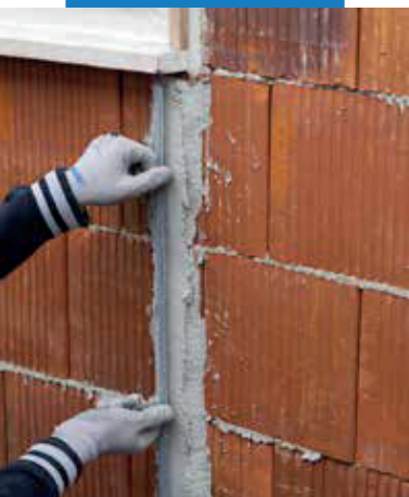
Установка вертикальных направляющих маяков
