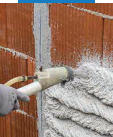
Нанесение Intomap 535 (Интомап 535) с помощью штукатурной станции
